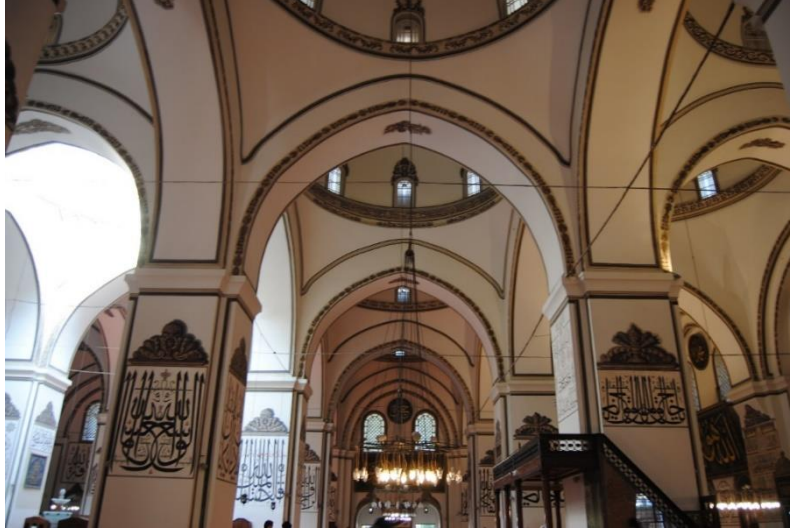
Şekil 4: Taşıyıcı ayaklar, sivri kemerler ve pandantifler
