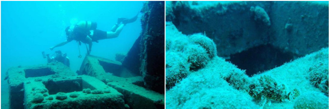
Şekil 25: Hekim adası civarına 1991 yılında yerleştirilen kübik beton yapay resifler
